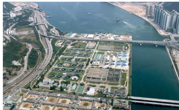
水/污水處理設施
