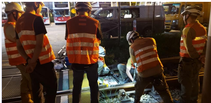
軌道跟崗學習- 輕鐵系統軌道的道岔維修
