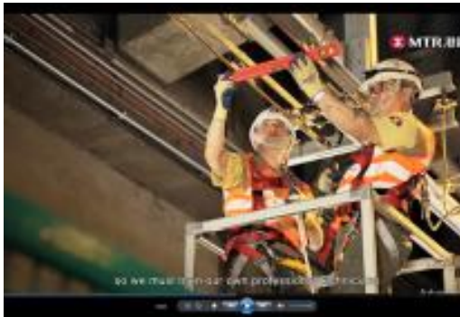
配電系統維修
