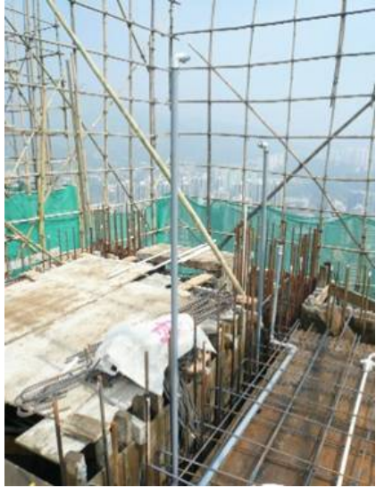
暗藏管道安裝
