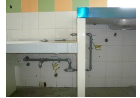
外露管道安裝
